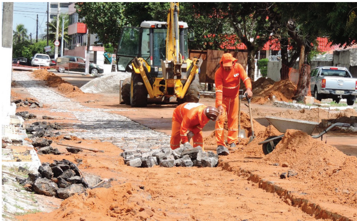
Mensalmente, o Grupo de Acompanhamento de Obras (GAO) da Caern, define em quais ruas serão realizadas as obras e também as frentes de trabalho
